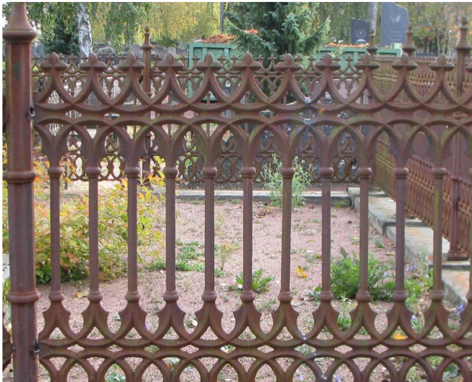
2000-luvun alussa Markku Heino ja Kimmo Salminen hitsasivat ajan saatossa irronneen aitaosan paikalleen.
